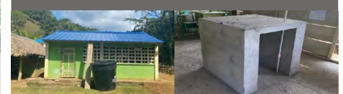
Pour cette école, nous avons refait la toiture et le système de tuyauterie afin de permettre une collecte plus optimale de l'eau de pluie. Une cuve de 10000 m 3 a été enterrée juste à côté avec un système de pompe fonctionnant grâce à des panneaux solaires.
