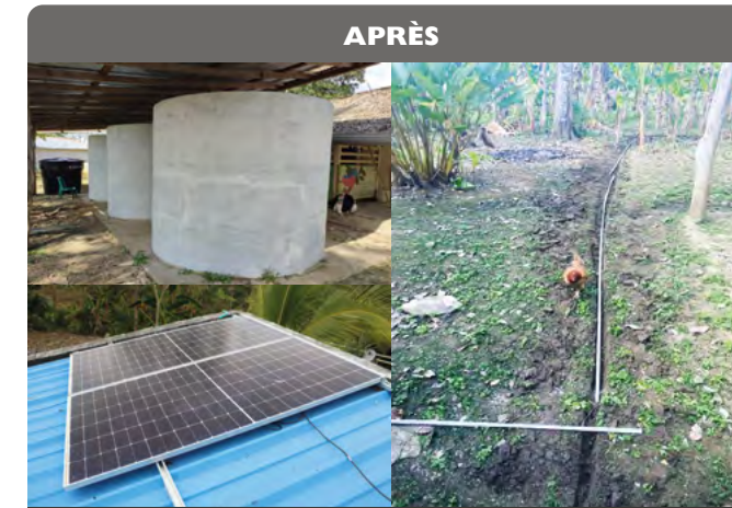
L'école de Carlos Ospina a été totalement équipée : réservoirs de stockage d'eau d'une capacité de 30000 m 3 , panneaux solaires avec une pompe servant à l'acheminement de l'eau et nouvelles gouttières pour récupérer les eaux de pluie. Nous avons également construit un système d'adduction d'eau et renouvelé entièrement le réseau de distribution d'eau. Désormais l'école est en capacité de collecter l'eau mais aussi de la stocker pour pallier les périodes de sécheresse.
